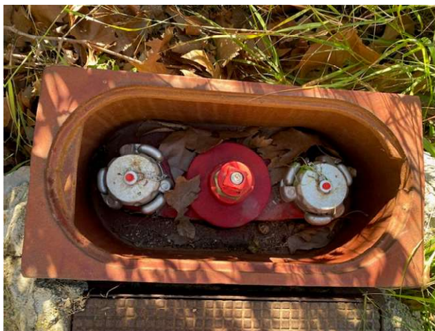
Imagen 23 - Hidrante de columna e hidrante soterrado en Puigpunyent (fuente Ayuntamiento de Puigpunyent)
