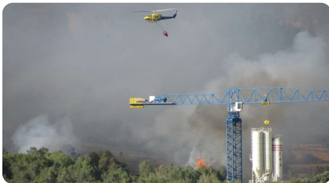
Figura 19. Incendio de Benicolet (Valencia) en 2011. Afección a perímetro de zona industrial. Presencia de obstáculos que dificultan la navegación aérea, así como otros elementos peligrosos. Fuente: Ferran Dalmau
