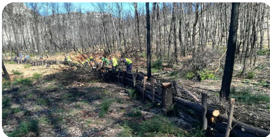
Figura 24. Trabajos de defensa contra la erosión enmarcados en la fase de recuperación posincendio forestal de Llutxent (València, 2018). Fuente: Medi XXI GSA.
