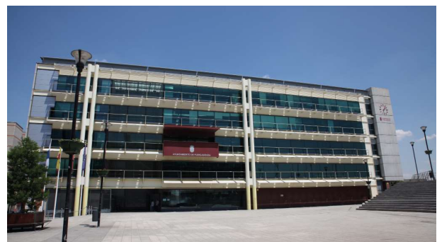
Fig. 2 Edificio del Ayuntamiento de Fuenlabrada
