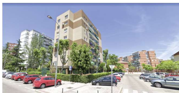
Fig. 4 Edificios residenciales en Fuenlabrada.
