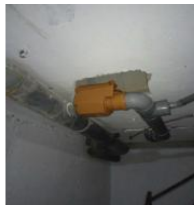
Válvula de retención en acometida de alcantarillado.
