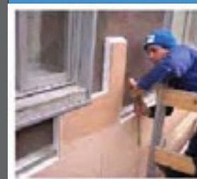
Aislamiento por el exterior sin cámara Punto JACAR
