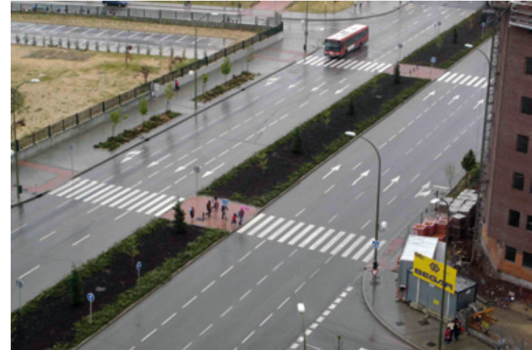
Cruce peatonal de longitud excesiva
