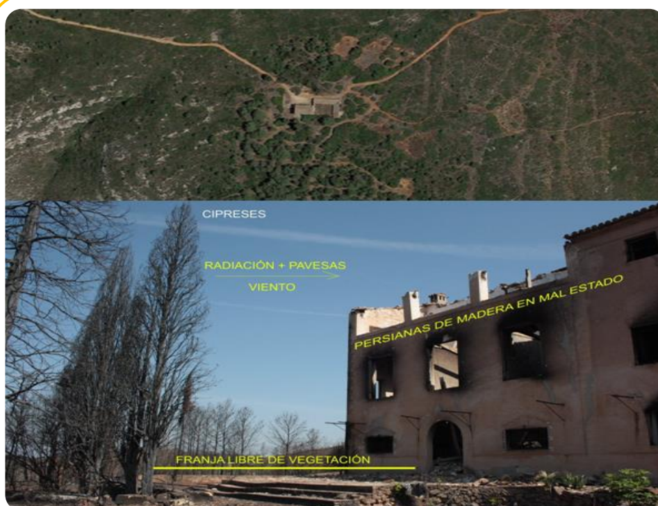
Figura 5. Construcción aislada afectada por el incendio de Carcaixent (Valencia) en 2016. Fuente: Ferran Dalmau
