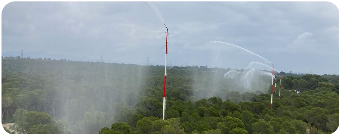
Figura 40. Red de riego sobre cortafuegos verde aprovechando el agua regenerada de la ERA local (no se utiliza agua potable). Parc Natural del Túrria (València). Fuente: Medi XXI GSA
