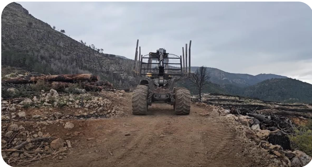
Figura 47. Trabajos de restauración post-incendio con hidrotecnias de protección del suelo mediante construcción de fajinas (para reducir erosión por escorrentía) y extracción de biomasa quemada para financiación de trabajos de mejora. Incendio de Montitxelvo (València, 2023). Fuente: Medi XXI GSA
