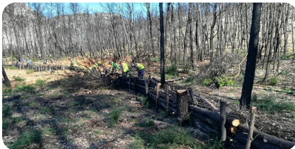
Figura 46. Trabajos de defensa contra la erosión enmarcados en la fase de recuperación posincendio forestal de Llutxent (València, 2018). Fuente: Medi XXI GSA.
