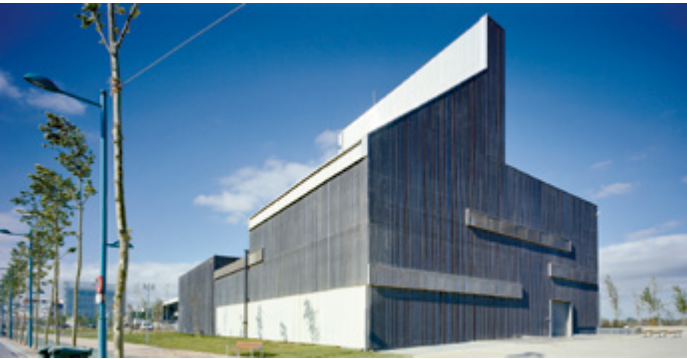
Central de producción de la red de calor y frío de Zaragoza
