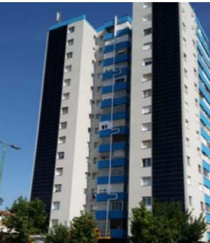
Paneles solares fotovoltaicos en la fachada
