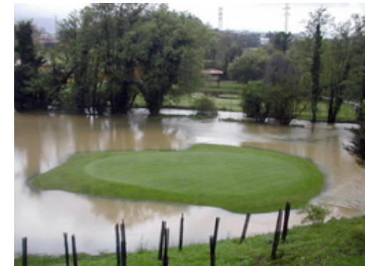
Campo de golf de El Tragamón donde se aprecia como el campo ha sido diseñado de manera que siga funcionando como regulador de avenidas sin dañar las zonas delicadas como los greens.
