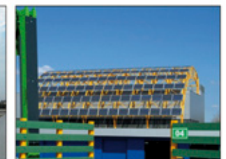
LIPASAM (Central de recogida neumática Pino Montano)
