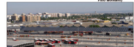
TUSSAM (Aparcamiento de autobuses)
