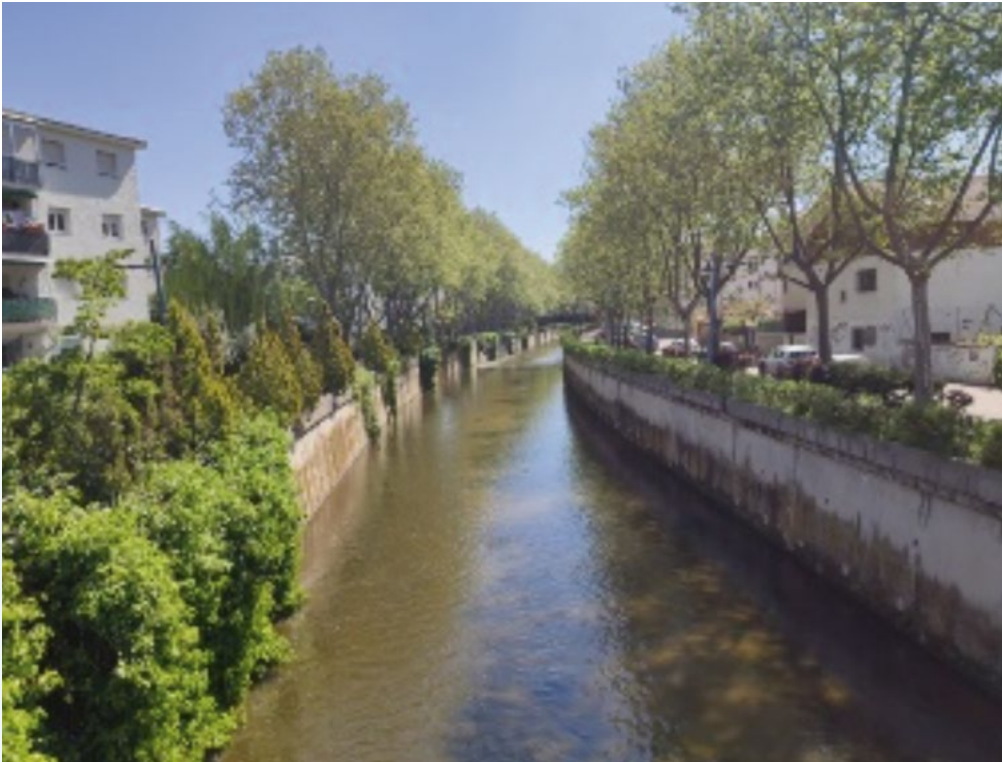
Imágenes 2. Proyecto del año 2005. Represas en cauce del río y mejoras en ajardinamiento y zonas verdes colindantes, incluida la colocación de jardineras en ambos márgenes
