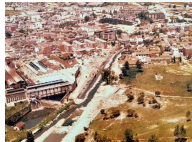
Imágenes 1 Ejecución del proyecto de encauzamiento del río Guadarrama y Arroyo de La Poveda (finalizado en el año 1983).
