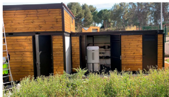
Figura 1.4 - Caldera de biomasa CEIP Àngel Guimerà. Fuente: Termosun
