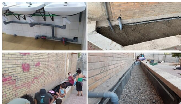
Figura 2.5 - Obras de depuración de aguas grises en el CEIP Mar Mediterráneo de Almería Fuente: Diario de Almería
